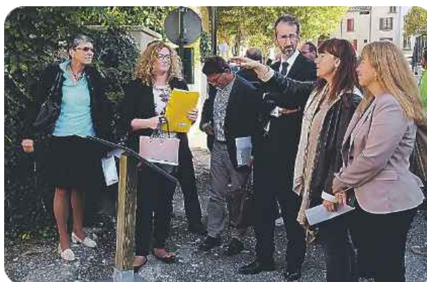
Visite du chantier de l'Écoquartier de Volonne par le préfet Olivier Jacob (photo : Haute-Provence Info)
