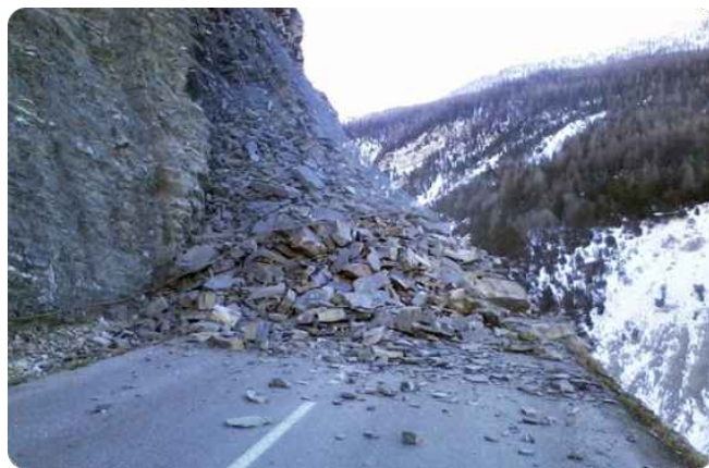
Éboulement rocheux sur la RD 900 le 7 février 2018
